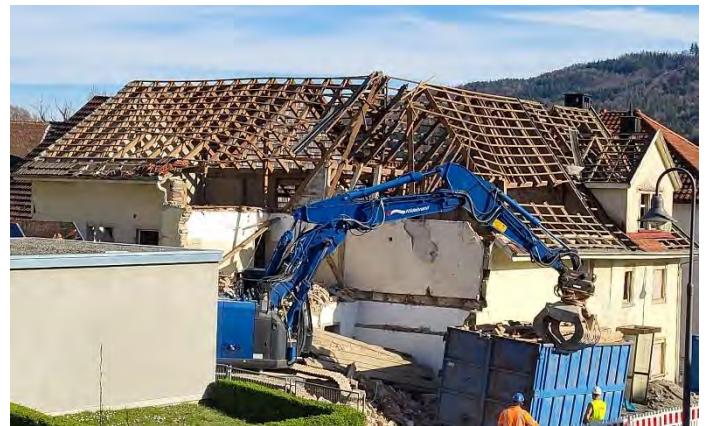
Aktueller Abriss in der Bohlinger Dorfstraße
